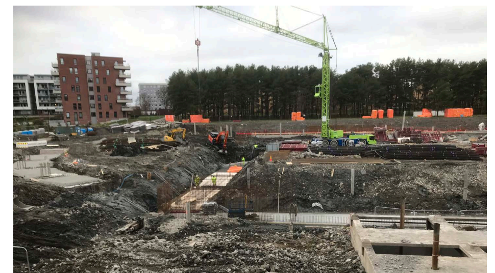
Anlegget pr. 18. november 2022. Vi ser at man er i ferd med å bygge dekket i søndre sving.
